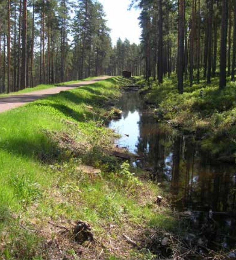
Nya Krondiket byggdes efter Polhems idéer på 1700-talet. På dammvallen går en väg och vattnet i diket används än idag.
