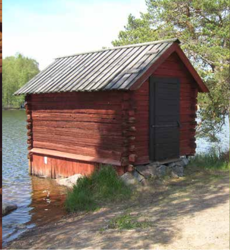
Dammhuset vid Korsgårdsdammen är det äldsta bevarade och fanns före 1691.
